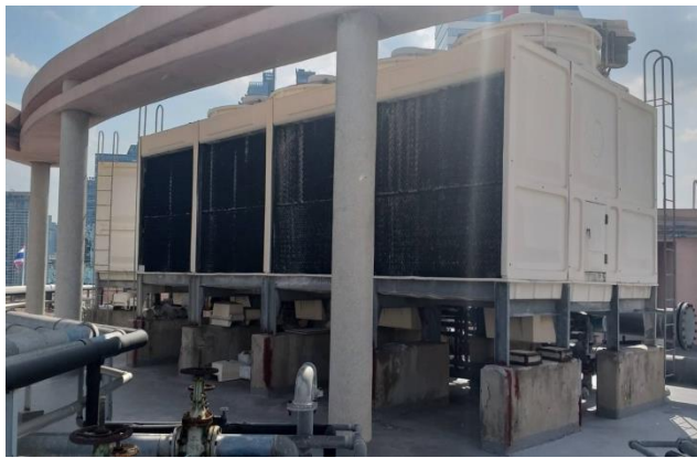
ภาพแสดง ระบบระบายความร้อนด้วยน้ำของเครื่องปรับอากาศ
